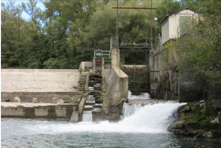
Figuras 3-4. Escalera de peces de la presa de Sossís en el año 2018. En el detalle de la imagen derecha se observa como el último estanque de la escalera acaba por encima del nivel habitual del agua, impidiendo la entrada de peces, y que ya se ha retirado la mayor parte de la red antidepredadores para acceder a su interior y limpiarla.
