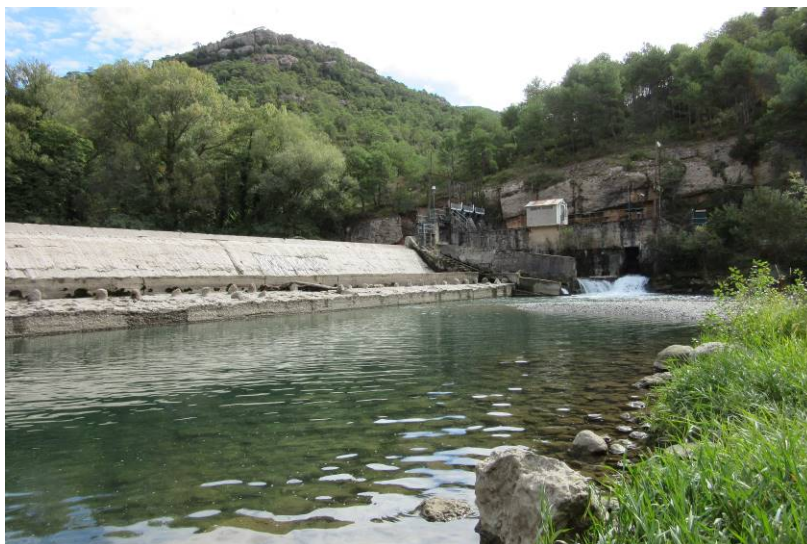
Figura 23. Presa de Sossís, con el estanque que se ha formado a su base, y que ocupa todo el ancho de la presa, con una superficie de 1.460 m 2 . En este punto se propone efectuar el rescate de peces antes de las obras.
