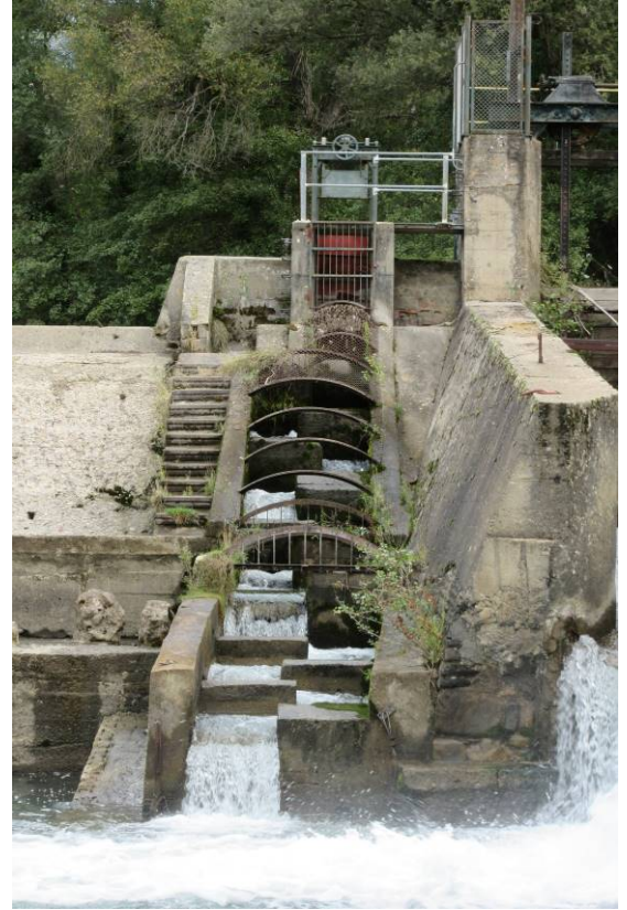
Figuras 3-4. Escalera de peces de la presa de Sossís en el año 2018. En el detalle de la imagen derecha se observa como el último estanque de la escalera acaba por encima del nivel habitual del agua, impidiendo la entrada de peces, y que ya se ha retirado la mayor parte de la red antidepredadores para acceder a su interior y limpiarla.
