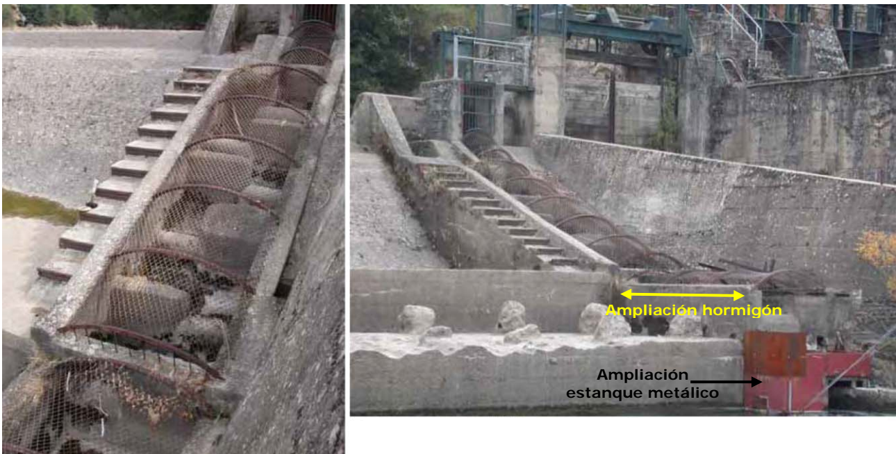
Figuras 1-2. Escala de peces de la presa de Sossís en el año 2006 (Ordeix et al. 2006). A la izquierda se observa como la malla antidepredadores tapaba toda la escala, y a la derecha se ven las dos modificaciones hechas para recuperar su funcionalidad: la primera construyendo 4 estanques sucesivos de hormigón, y la segunda instalando un último estanque metálico, que una avenida se llevó.
